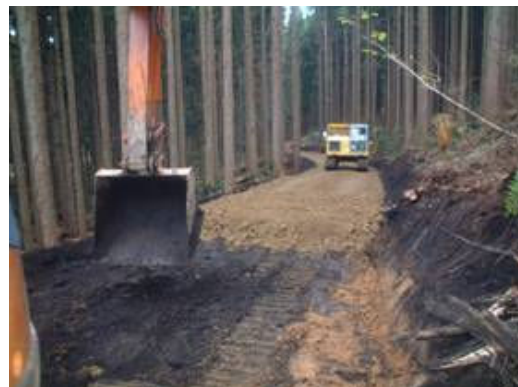
山土砂による安定基盤の確保
