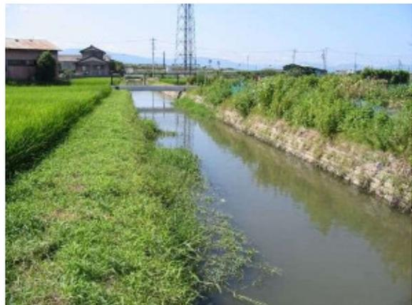
木製ブロック護岸の隙間からも植生が回復している。
