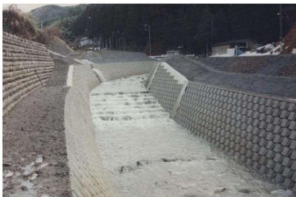
円光寺橋より 160m 程上流（郡上市大和町大間見地内）。川底に高低差（落差）がある箇所では、川幅全体にわたって、斜路工を設置した。また、合わせて柵田式魚道を設置した。
