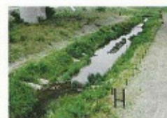
復元工法実施後の写真
