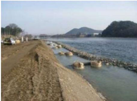
濁水の流出防止のための仮設沈砂池の設置
