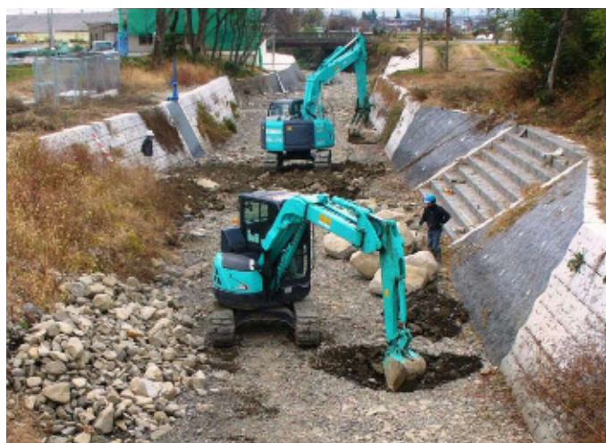
図-3. 6. 4 石出し水制工の施工状況
