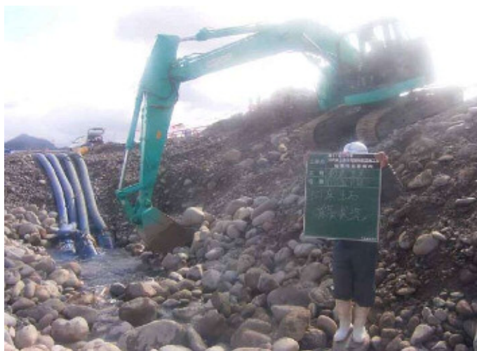
図-3.6.6 バックホウによる玉石の選別状況(長良川床上事業)
