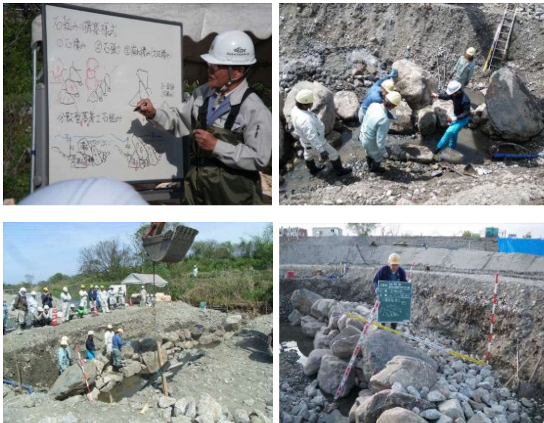
図-3.6.2 石組み落差工の施工状況写真
