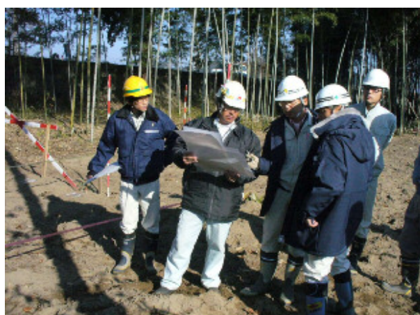
図-3.6.8 丁張りにより樹木の位置と設計図面の関係を現地確認(長良川)
