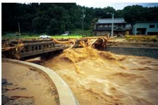
9. 15豪雨(平成11年度) 殿川(飛騨市古川町笹ヶ洞地内)
