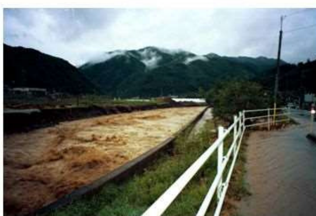
9. 15豪雨(平成11年度) 殿川出水状況 (飛騨市古川町信包地内)
