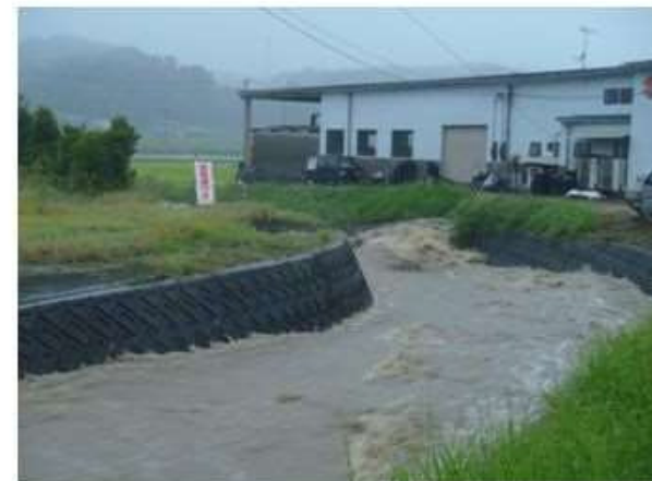
台風15号(平成23年度) 切木川出水状況 (御嵩町中切)
