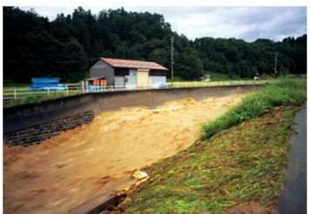
9. 15豪雨(平成11年度) 殿川出水状況 (飛騨市古川町笹ヶ洞地内)
