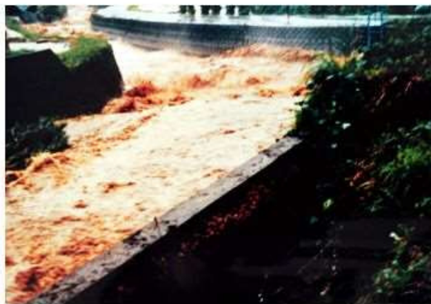
9. 15豪雨(平成11年度) 戸市川出水状況
