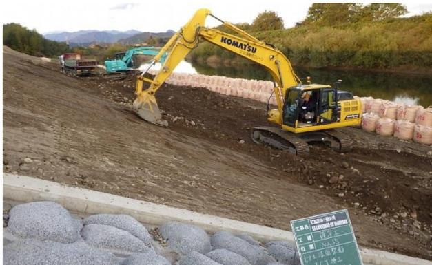
MCバックホウによる法面整形 施工状況
