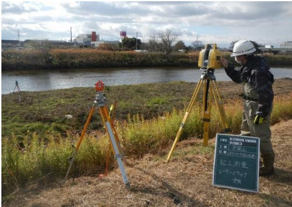
地上型レーザースキャナによる起工測量
