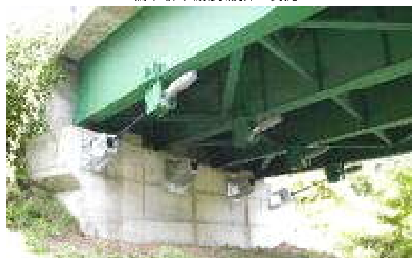
橋りょう耐震補強の状況
