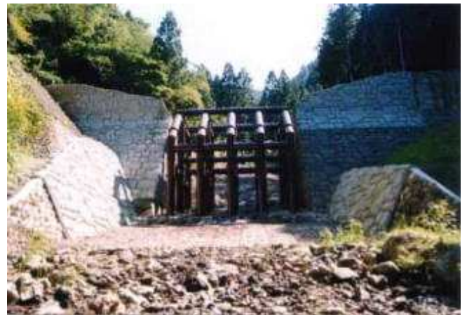
スリット式砂防えん堤
