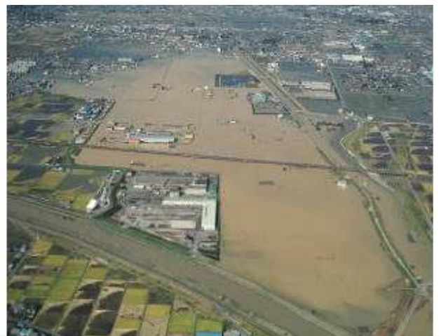
平成16年10月台風23号による浸水被害（大垣市）
