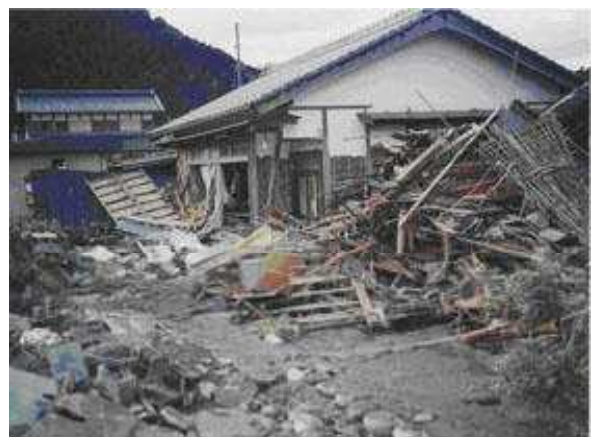
川上川（高山市清見町藤瀬）の被災状況
