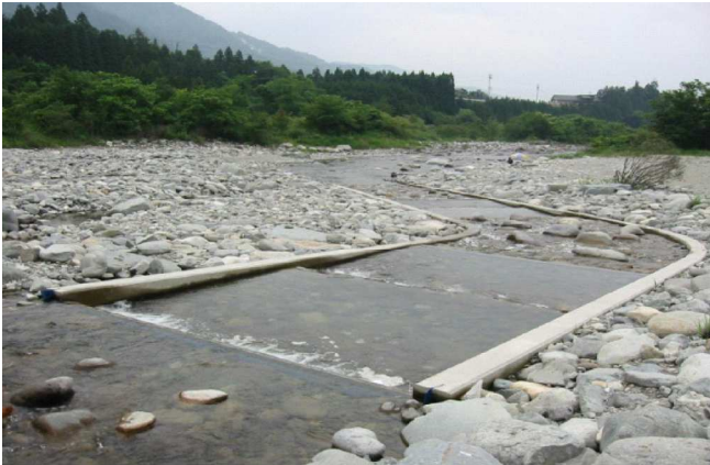
エコ・リバー実施箇所（魚道の設置）
