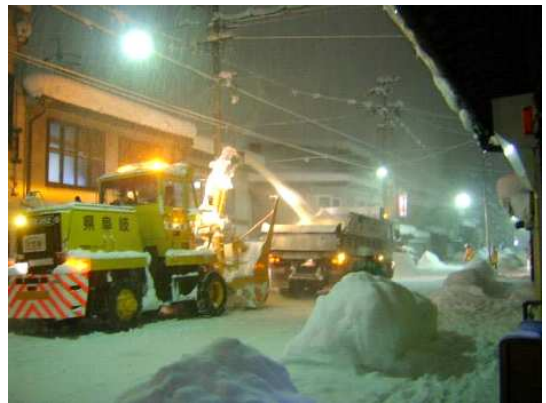
早朝からの除雪には地元の建設業者が不可欠
