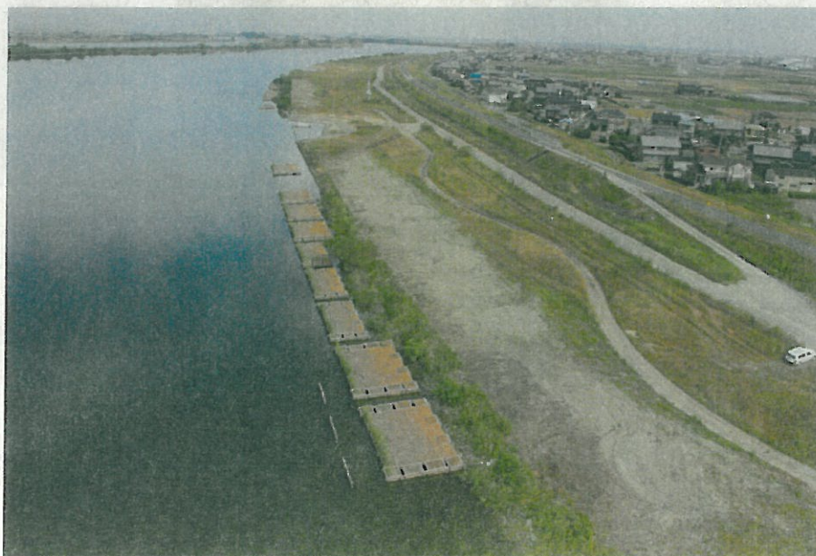
施工箇所を上空から望む（施工直後）
