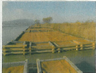
ヨシ根土流出防止ネット
