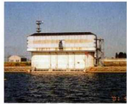
長良導水取水口(平成10年4月取水開始)
