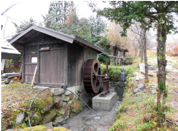
設置した小水力発電施設
