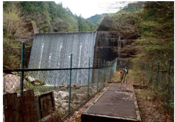
取水口(白川町)
