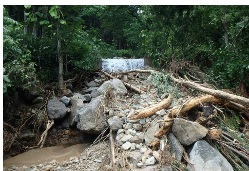
溪流内にある不安定な土砂
