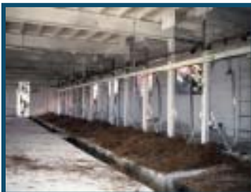
石灰乳の塗布
