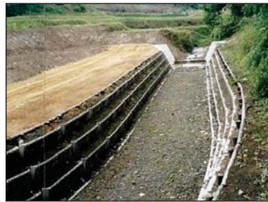
カゴ系ブロック工の施工直後 (平成13年撮影)
