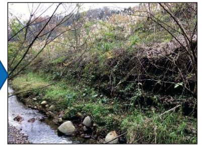
カゴ系ブロック工の植生状況 (平成30年10月撮影)
