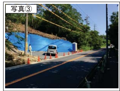
写真③ 起点：国道248号との接続予定箇所
