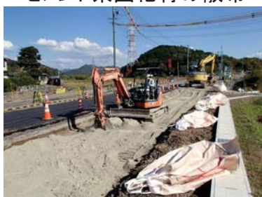
セメント系固化材の散布
