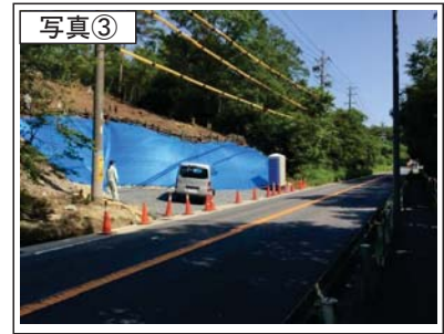
写真③ 起点：国道248号との接続予定箇所
