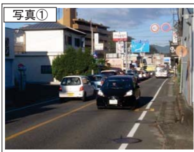
写真① (主) 豊田多治見線 現道の状況
