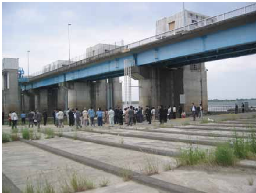
木曾川大堰(平成15年5月30日)
