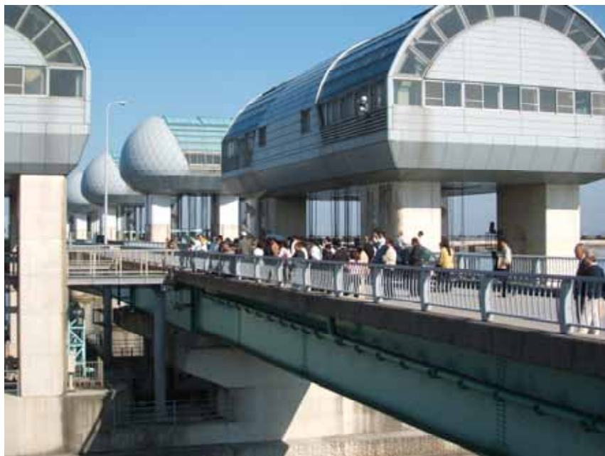
長良川河口堰(平成17年10月27日)
