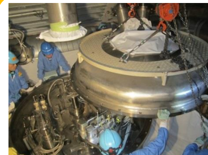
缶詰装置容器開放点検 (平成29年9月～)
