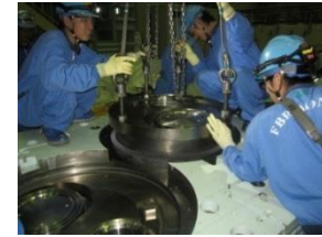
炉外燃料貯蔵設備 床ドアバルブの点検 (平成29年7月～10月)
