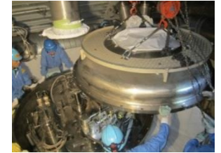
燃料缶詰設備容器開放点検 (平成29年9月～)
