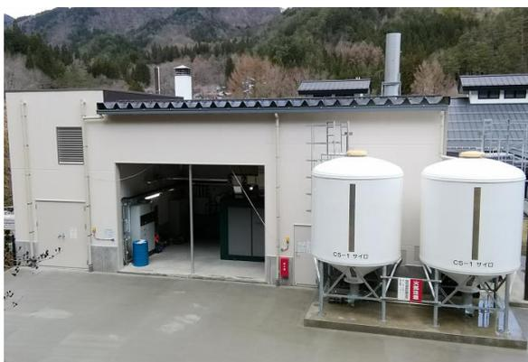
温泉施設に導入された木質ペレットガス化熱電併給施設（高山市）
