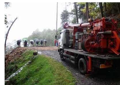
路網と作業システム（タワーヤーダー）
