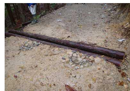
路面排水の不備補完のため 自力で追加施工した横断溝
