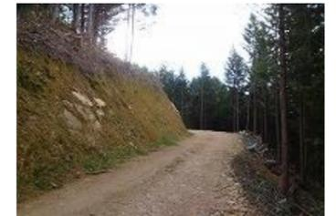
全切り工法による作業道開設
