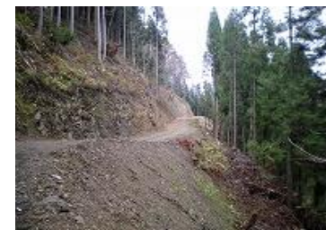
急傾斜地に開設 された作業道
