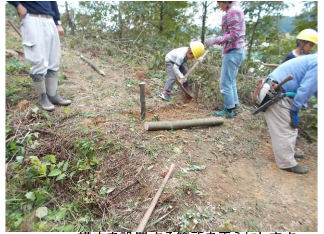
横木を設置する箇所を平らにします。
