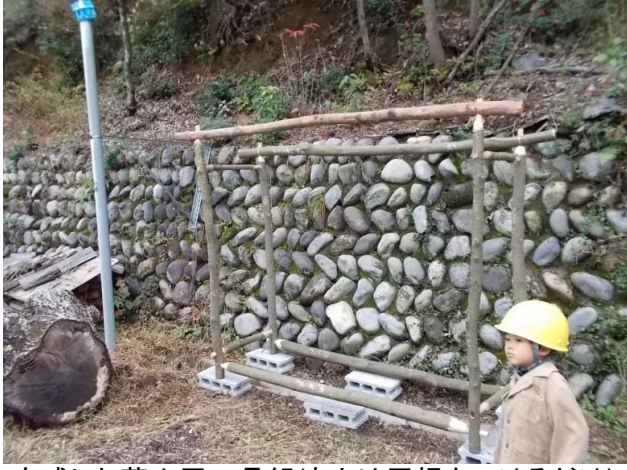
完成した薪小屋の骨組(あとは屋根をつけるだけ)
