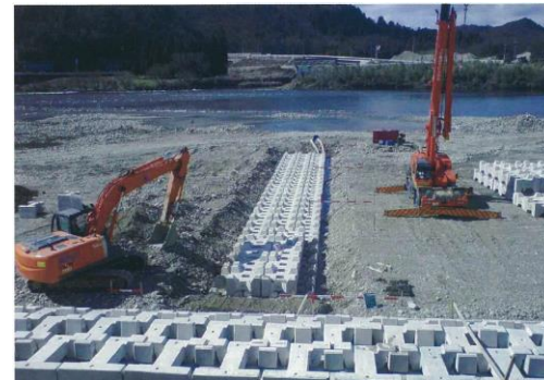
水制工の設置 (保戸島地区)
