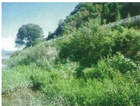
覆土護岸による河岸植生の回復状況 (岩田西地区)
