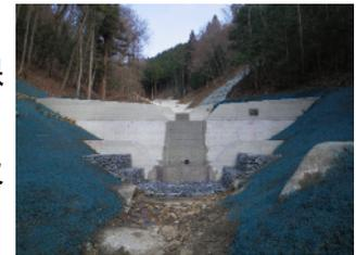
谷止工の施工（瑞浪市）
