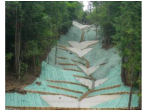
災害関連緊急治山施工地（八百津町）
