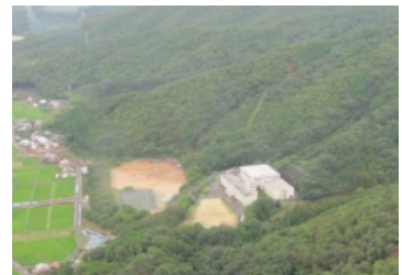
被災箇所(八百津町)
