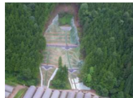
崩壊地の復旧を図る山腹工（高山市）
