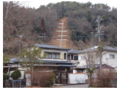
復旧状況(H23.2)
