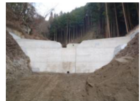
谷止工の施工(瑞浪市)
