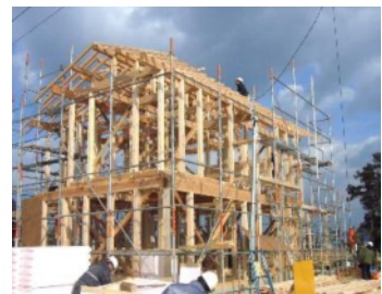
県産材住宅の建設現場
