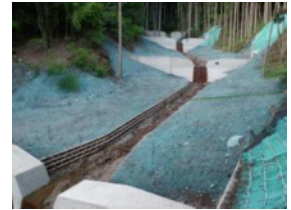
治山施工現場（恵那市）
