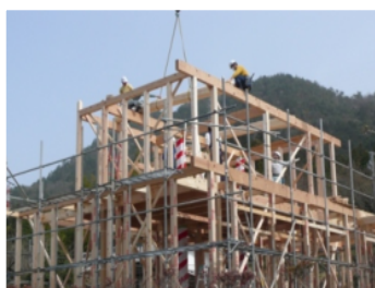
県産材住宅の上棟
