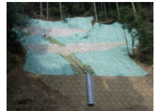
山腹整備状況（垂井町）
