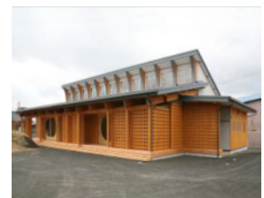
木造化施設〔保育園屋内運動場（美濃加茂市）〕
