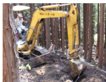
作業道開設実習
