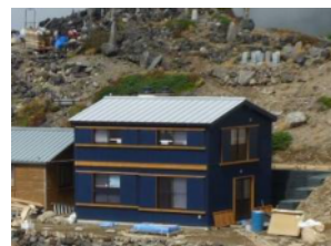
御嶽五の池小屋(下呂市)
