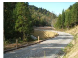
林道「宮谷～明ヶ谷線」（高山市）
