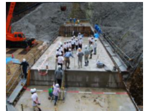
治山工事見学会の様子（白川町）
