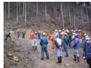
作業道開設研修(関市)
