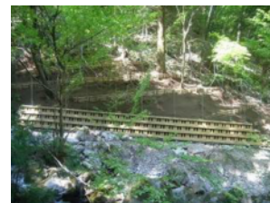
石ブロックを使用した治山工事(下呂市)
