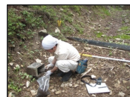
作業路の現地調査
