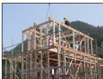
県産材住宅の上棟
