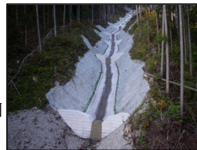
復旧治山事業施工地（中津川市）
