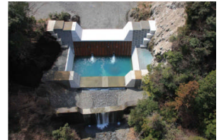
流出土砂対策（揖斐川町）
