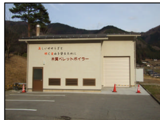
木質ペレットボイラー施設
