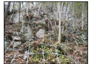
治山事業による落石対策（関市）
