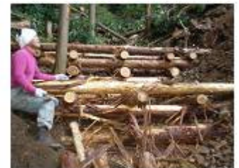
丸太組工の施工状況
