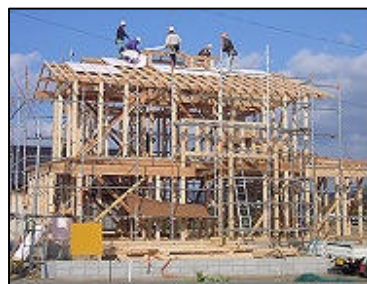
県産材住宅の建設現場
