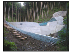
谷止工の施工（七宗町）
