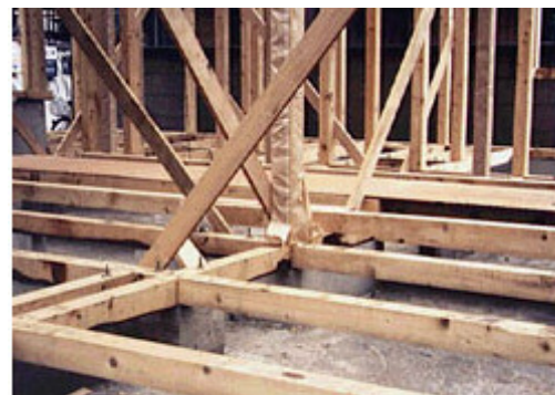
住宅の土台に使われている正角
