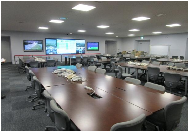
栃木県・情報集約センター
