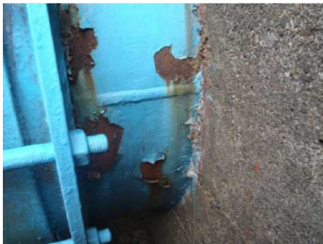
塗装の変状 (さび)
