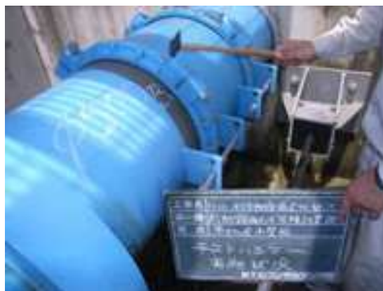
写真 2.2-9 テストハンマーによる打診調査状況
