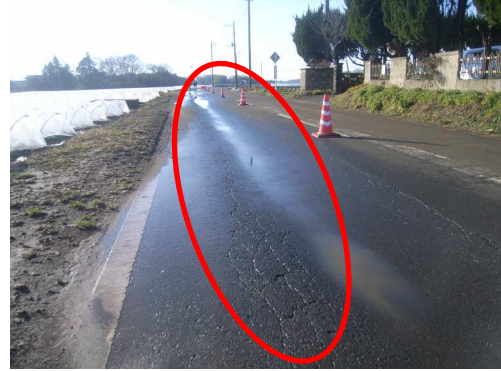
路面のひび割れ、沈下
