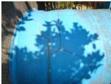
塗装の変状 (われ)
