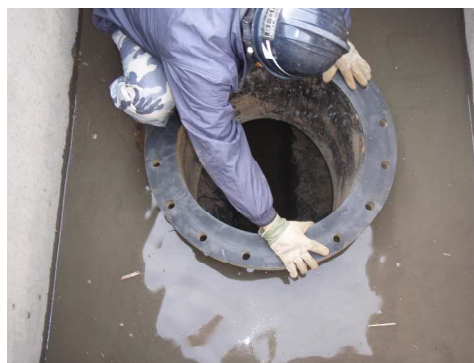
写真 2.3-7 パッキンの交換状況
