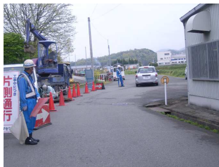
写真 2.3-1 安全施設・交通誘導員の配置
