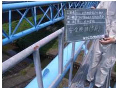
歩廊の塗装の変状 (さび)
