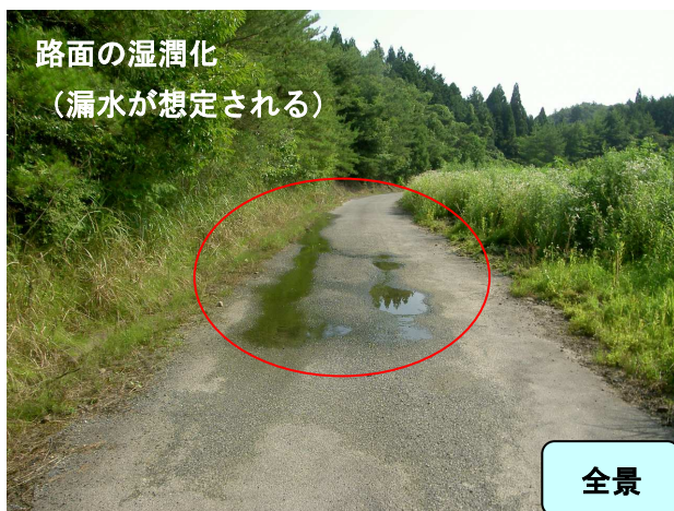
写真 2.2-6 地上部の漏水
