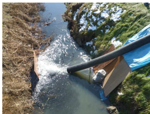
写真 2.3-4 法面侵食対策の状況
