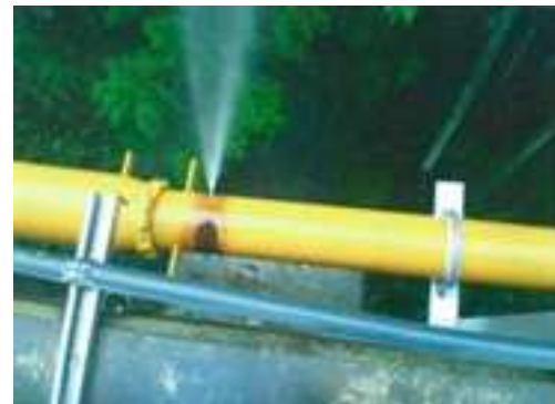
添架管路の異常（漏水等）
