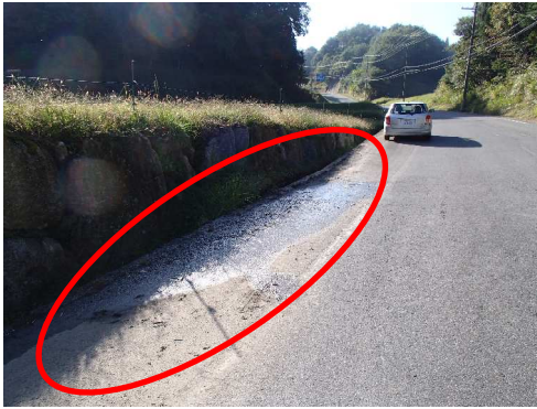
漏水（漏水痕跡）
