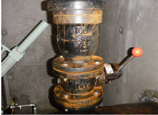
塗膜の劣化（さび）
