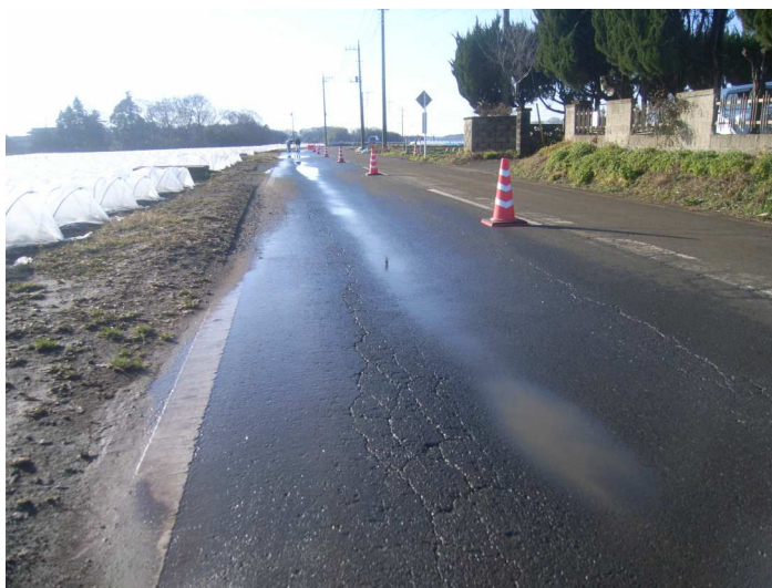
写真 2.2-5 埋設管路の沈下に起因した路面の陥没
