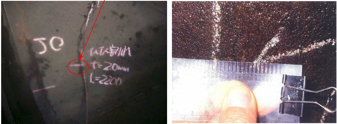
写真 2.2-2 ひび割れの監視状況
