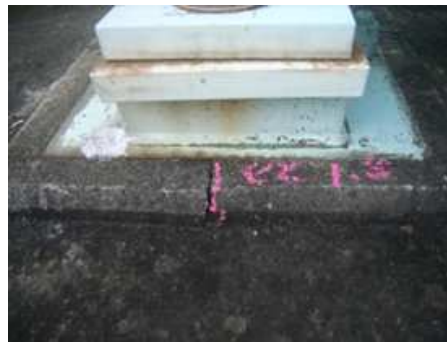
台座コンクリートのひび割れ
