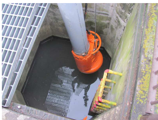
写真 2.3-3 ポンプ排水（水替え工）
