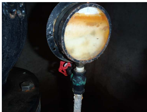
計器（圧力計）の故障（正常値を示していない）
