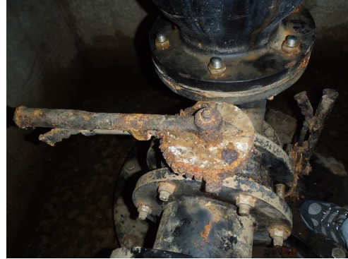
作動不良（補修弁レバーの固着）
