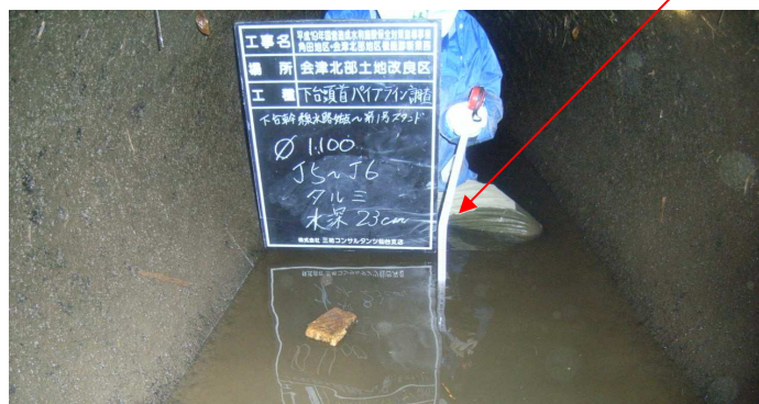
写真 2.2-3 残留水がある場合の沈下深さの計測
