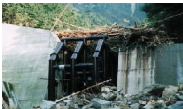
【流木を捕捉した砂防施設】 (流木捕捉：砂防事業)
