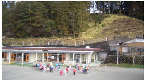
保育園の背後斜面に設置された擁壁工（中津川市）
