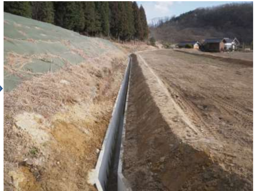
法尻に湧水処理を行うことで乾田化が図られた
