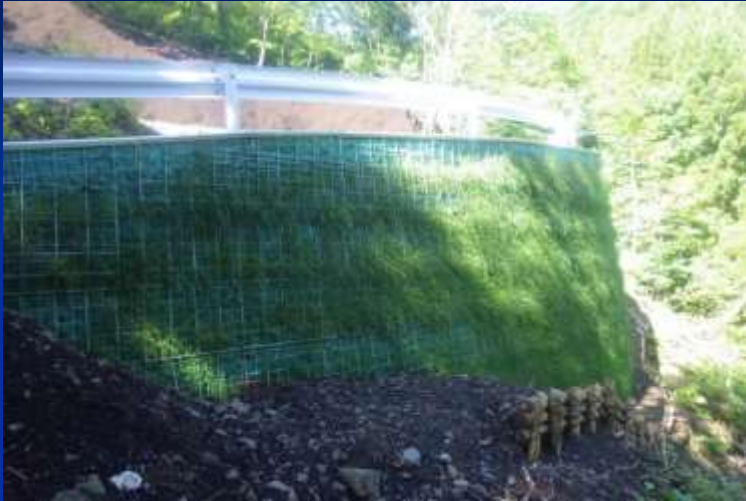
補強土壁工
