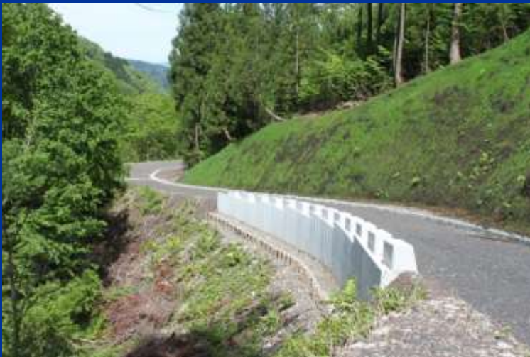
プレキャストL型擁壁工
