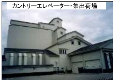
カントリーエレベーター・集出荷場
