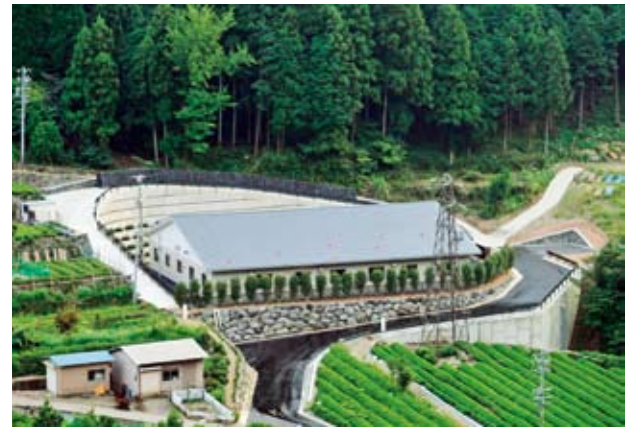
農業集落排水事業 春日地区
