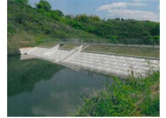
改修したため池 (美濃加茂市 小草場地区)
