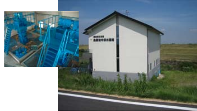
更新した排水機場 (羽島市 桑原地区)
