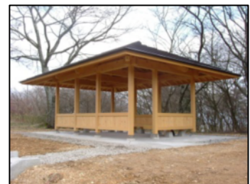
東海自然歩道の整備
