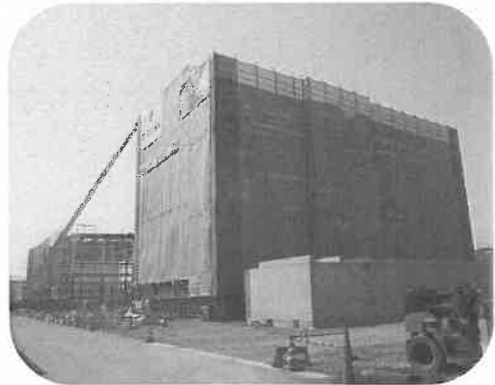
<建設中の木質バイオマス発電施設（瑞穂市）>
