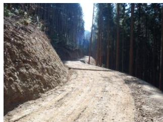
図-6 完成した基幹作業道
