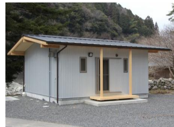
図-13 完成した木造仮設住宅『木づな』第1号
