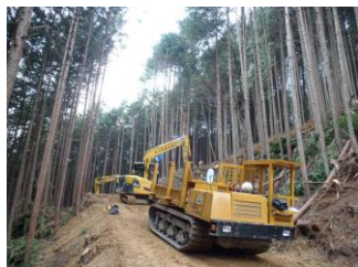
図-5 作業道開設状況
