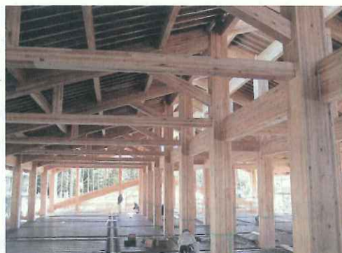
建設中の山岡小学校木造校舎
