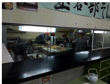
【既存調理場を改修】
