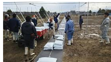
【設置作業の様子】
