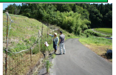
【水田周囲の柵の点検】
