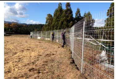
【防止柵の設置作業】
