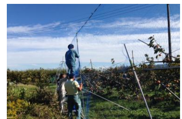
【柿園での資材設置作業】
