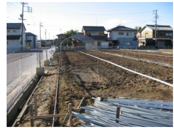
【羽島市建設中のアスパラハウス】
