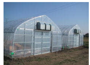
新規に建設されたハウス
