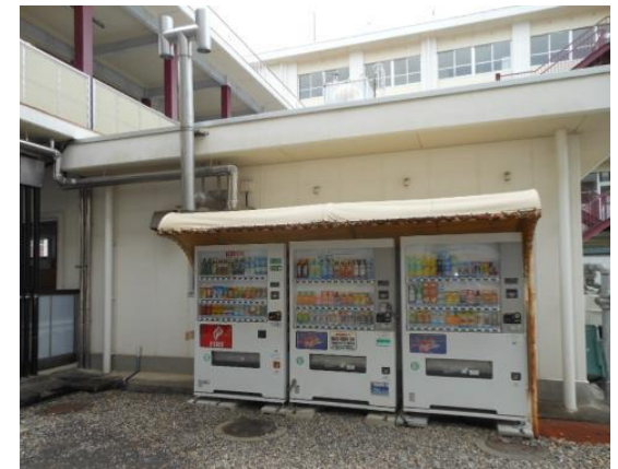
【校務員室棟北側設置現況】
